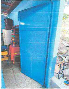
Foto7: Mantenimiento y reparación de puertas (chapas y pintura).
