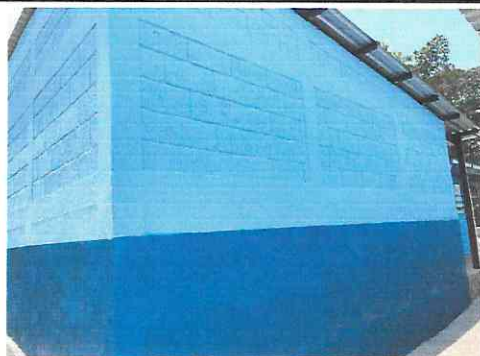
Foto 5: aplicación de pintura exterior e interior
