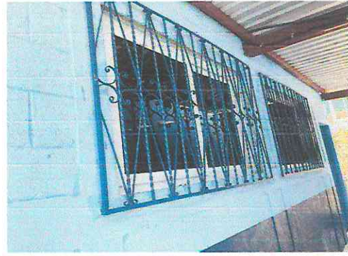
Foto 8: Mantenimiento de balcones
