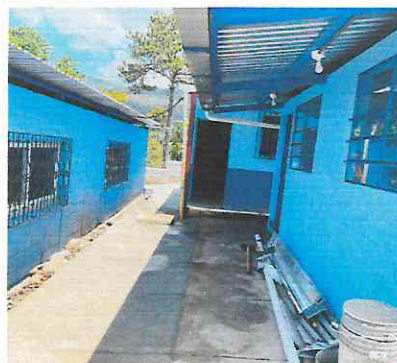
Foto 4: Mantenimiento de losa de patio
