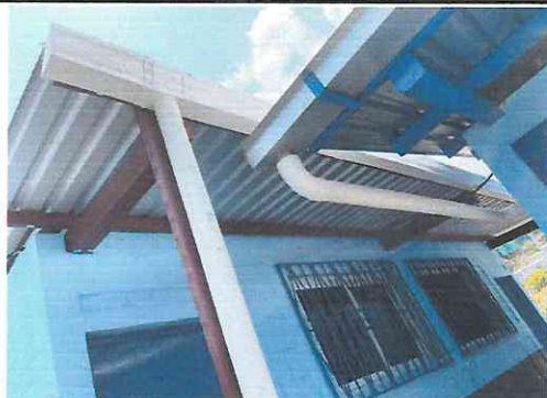
Foto 3: Cambio de Canal y bajadas de agua pluvial
