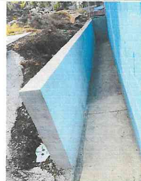
Foto 2: Reparación de Muro de Contención
