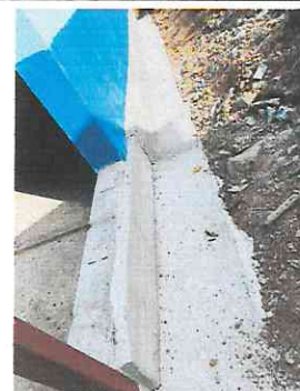
Foto 6: Reparacion de cuneta de concreto en exterior de aula
